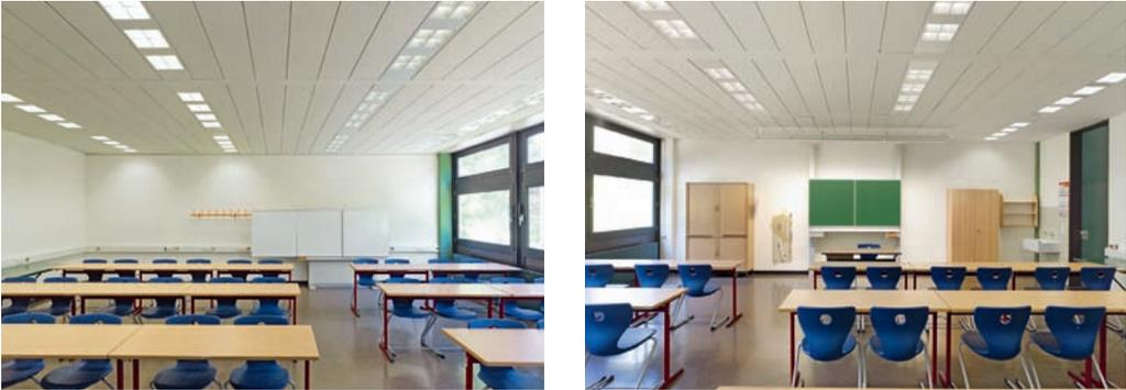
Abbildung 25: Typische Beleuchtungssituation in einem Klassenraum nach Umrüstung auf LED inkl. Tafelbeleuchtung und Tageslichtsteuerung © Philips GmbH
