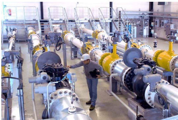
Bild 2: Grenzübergangsstation mit Volumen- und Gasbeschaffenheitsmessung (Quelle: Elster GmbH)
