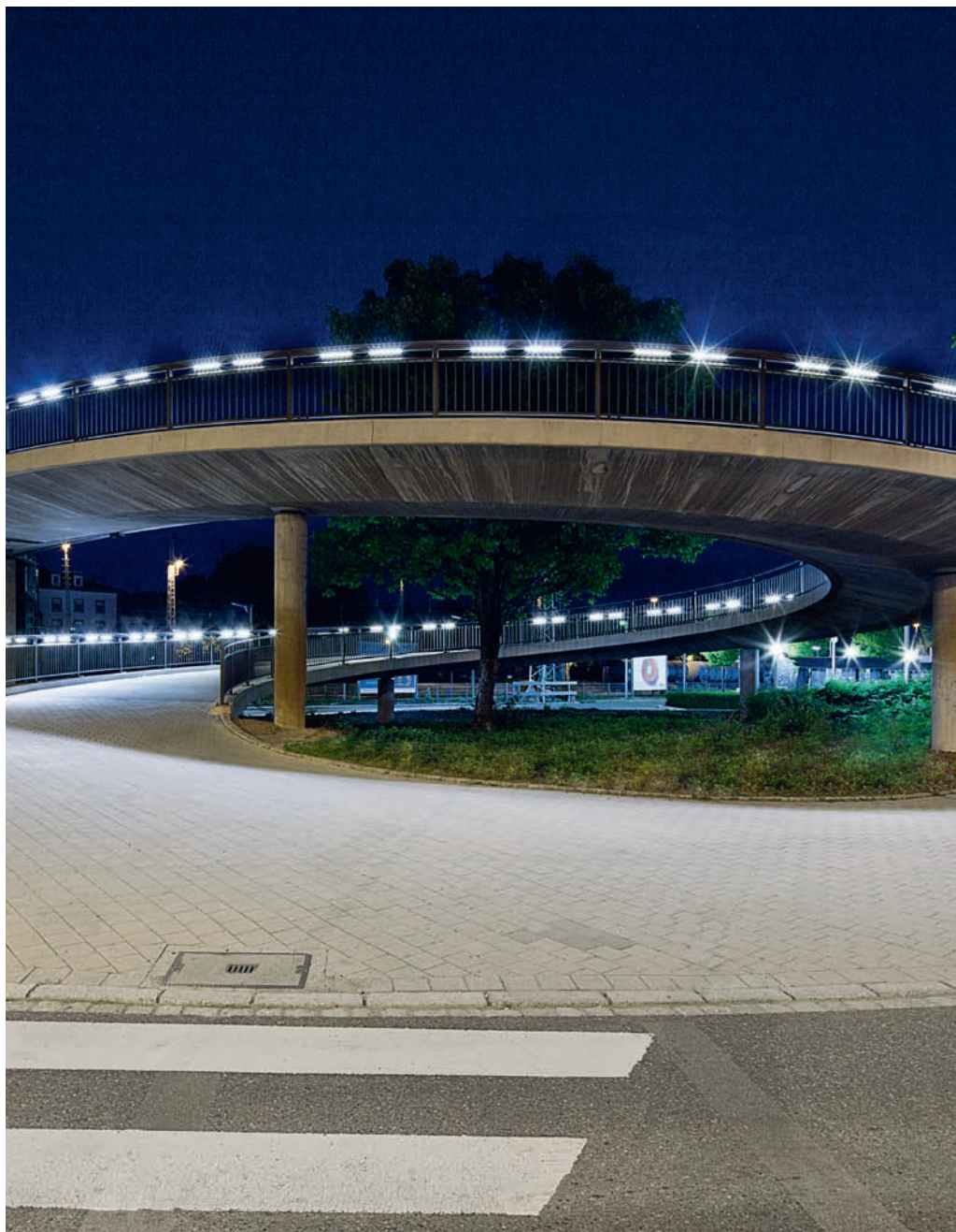
LED-Beleuchtung im Villingen-Schwenningen © Hess AG
