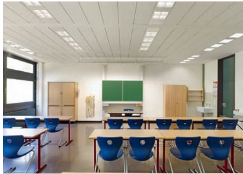
Abbildung 25: Typische Beleuchtungssituation in einem Klassenraum nach Umrüstung auf LED inkl. Tafelbeleuchtung und Tageslichtsteuerung © Philips GmbH
