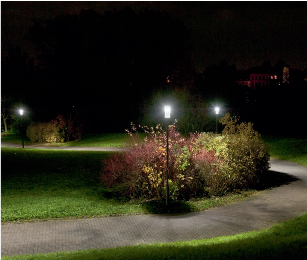
Abbildung 18: LED-Parkbeleuchtung in Görlitz © VDI Technologiezentrum GmbH
