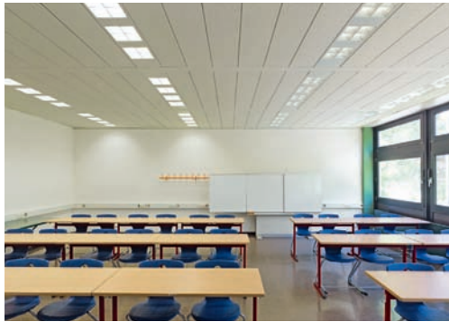
Abbildung 25: Typische Beleuchtungssituation in einem Klassenraum nach Umrüstung auf LED inkl. Tafelbeleuchtung und Tageslichtsteuerung © Philips GmbH
