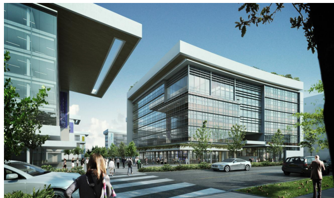
Bild 1: Gebäude des Forschungscampus DPP – Bezug im Herbst 2015 (Quelle: RWTH Aachen)
