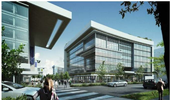
Bild 1: Gebäude des Forschungscampus DPP – Bezug im Sommer 2015 (Quelle: RWTH Aachen)
