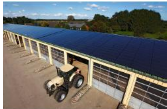
Bild 1: Aufdach Solaranlage mit PowerMax® Dünnschichtmodulen (Quelle: AVANCIS GmbH & Co. KG)
