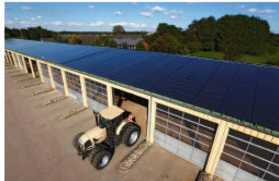
Bild: Aufdach Solaranlage mit PowerMax® Dünnschichtmodulen (Quelle: AVANCIS GmbH & Co. KG)
